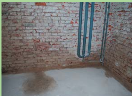
Město Třešť – Stavební úpravy Měst. kult. střediska v Třešti – sanace vlhkého zdiva
